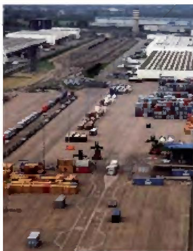
Un'area dell'interporto campano
